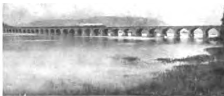
ROCKVILLE BRIDGE, PENNSYLVANIA R. R.
